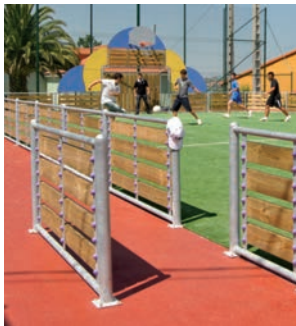
Madera tratada en autoclave, acero galvanizado y tornillería cincada.
